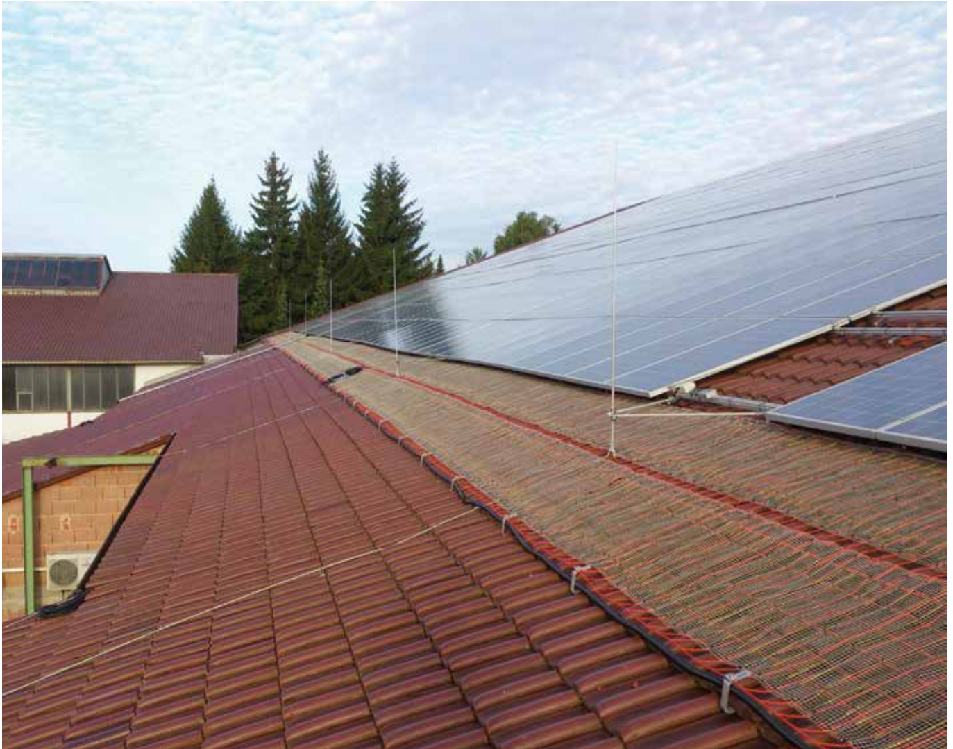
Heizmatte 172-DUSN, 175 W/m 2 , 230 V, IP X7, Heizleiterabstand: 10 cm
